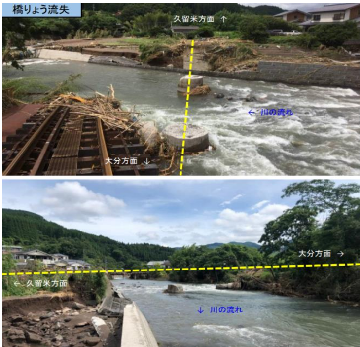
豊後中村～野矢駅間第二野上橋りょう
