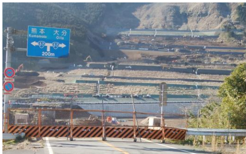
阿蘇大橋東側から見た現場【2020年3月6日】
