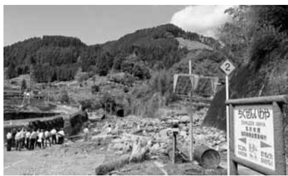
大量の土砂が残る筑前岩屋駅
